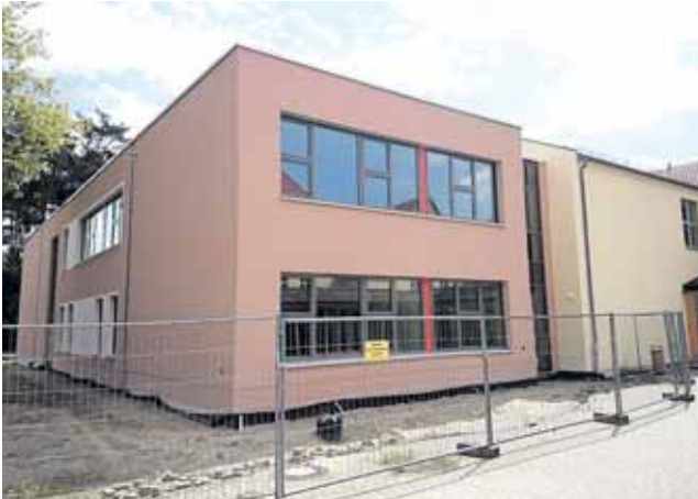
Der neue Anbau der Vier-Jahreszeiten-Grundschule wird pünktlich zum Schuljahresbeginn in Betrieb genommen. Fotos (2): Gemeinde
