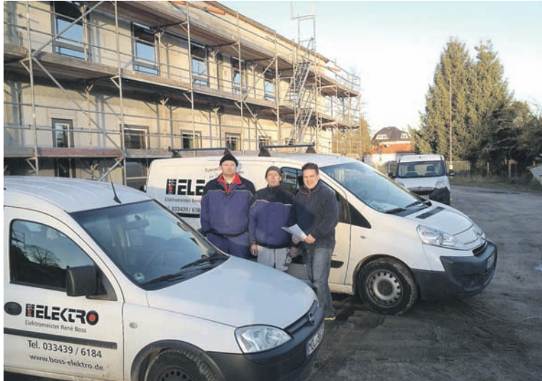
Chef René Boss (re.) mit den Kollegen André Mohr (li.) und Mario Ring vor der Baustelle des neuen Verwaltungsbaus der Gemeinde
