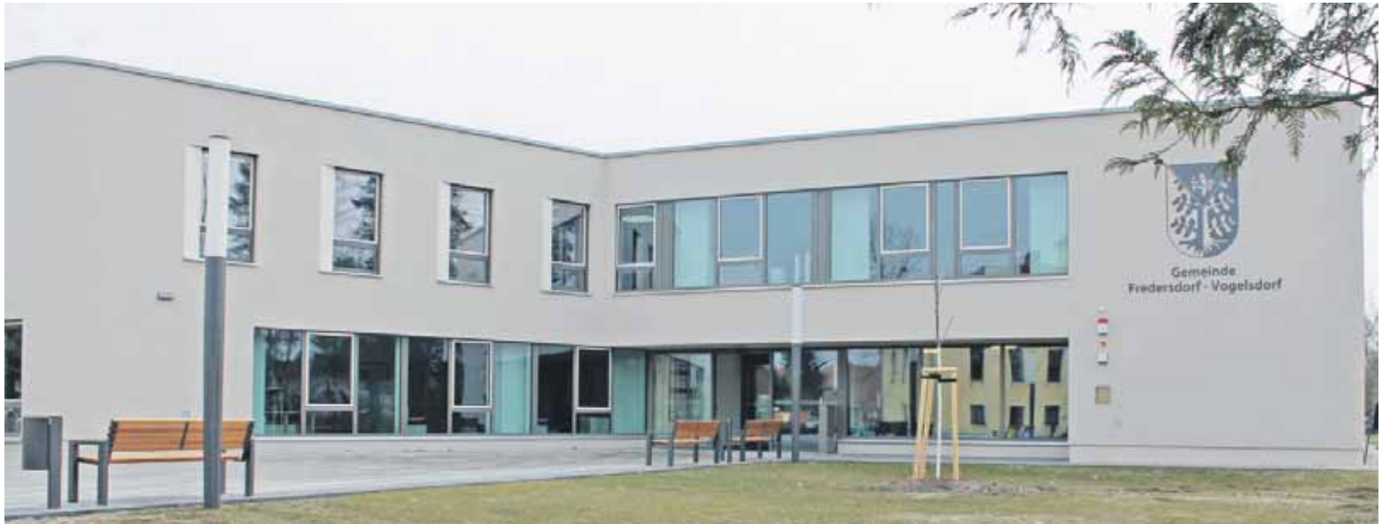
Besser für die Mitarbeiter, besser für die Bürger: Das neue Verwaltungsgebäude der Gemeinde Fredersdorf-Vogelsdorf in der Lindenallee. Am Samstag, 21. April 2018 sind alle Interessierten von 11 bis 14 Uhr zu einem Tag der offenen Tür eingeladen. Foto: S. Bey
