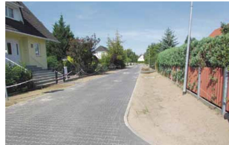
Der fertige Kornblumenweg: Wegen der geringen Flächen zur Versickerung von Regenwasser wurden (werden) die Straßen im Quartier 7 alle mit Betonsteinpflaster versehen.
