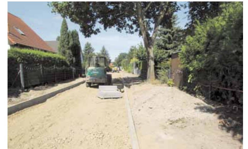
In der Neuen Straße finden noch Straßenbauarbeiten statt. Die seitliche Fahrbahnbegrenzung mit Tiefborden steht bereits.
