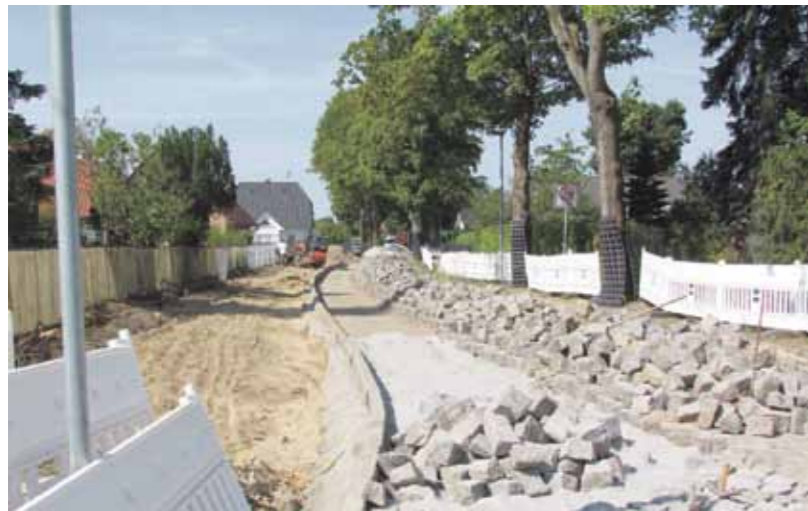
Blick in die Menzelstraße: Gut zu sehen ist der umzupflasternde Natursteinbereich der Fahrbahn mit gerichtetem Hochbord. Links die vorbereitete neue Gehwegtrasse.
