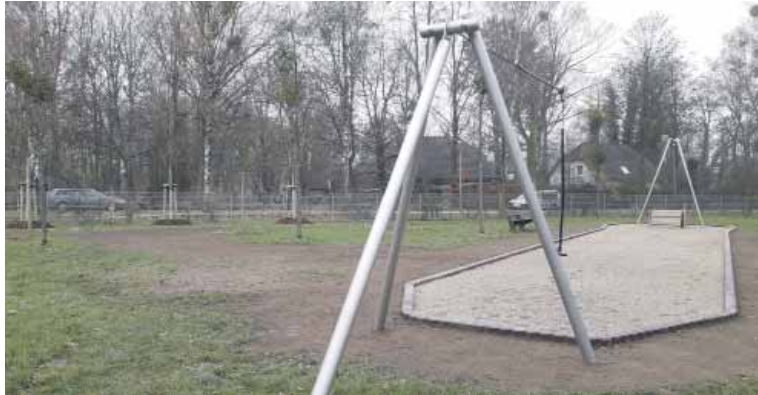
Im Falle eines Falles: Runterfallen ist hier nicht schlimm. Ein Fallschutz aus Kies ist nun eingebaut worden.
