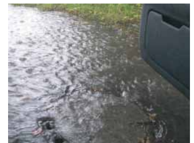
Typisches Bild in der Gemeinde: Abwasserschacht bei Regen. Foto: M. Arndt
