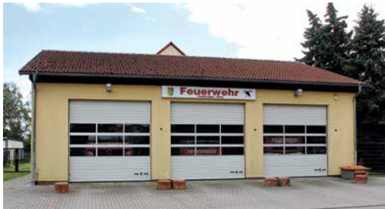
Gegenwärtiges Gerätehaus der Freiwilligen Feuerwehr Fredersdorf-Nord
