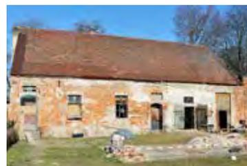
Fassade mit einem Glattputz versehen und das Traufmauerwerk erneuert.
