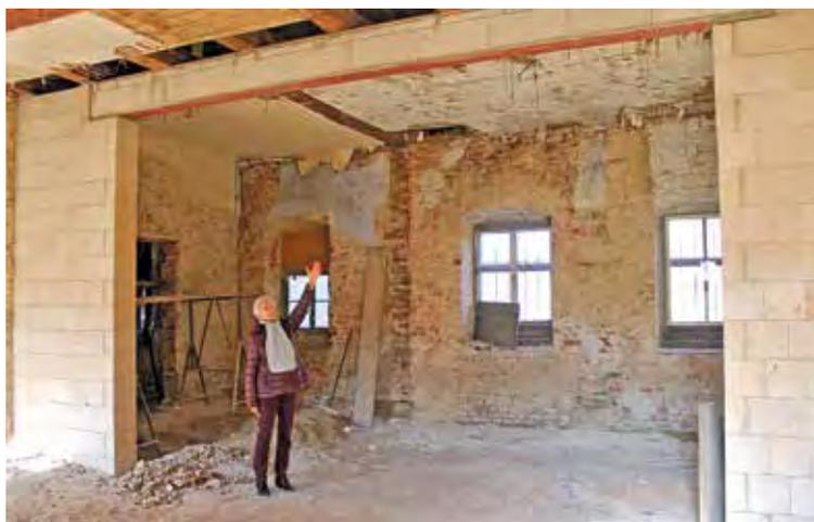
Dieser fünf Meter breite Durchgang ist neu: Zur Stabilisierung des Gebäudes wurden zwei Wände hochgezogen und ein Sturz aufgelegt.
