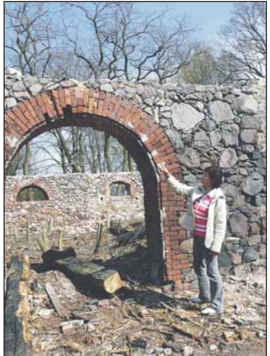
Hannelore Korth zeigt die Kuhstallmauer, die mit den Steinen wieder hergerichtet werden soll.
