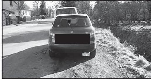
Aufzufahren und dadurch verdichteten Randstreifen kann das Wasser nicht mehr in die Entwässerungsmulden abfließen
