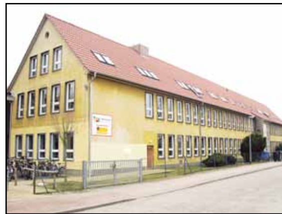
Haus 3, Oberschule Fredersdorf
