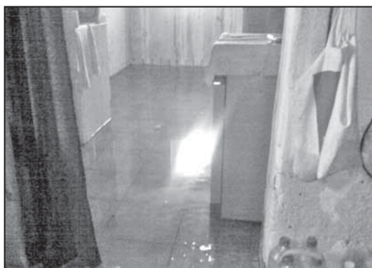
Wenn es zu einem Rohrbruch kommt, ist der Schaden in der Regel groß, die Wohnung wird überschwemmt ...
