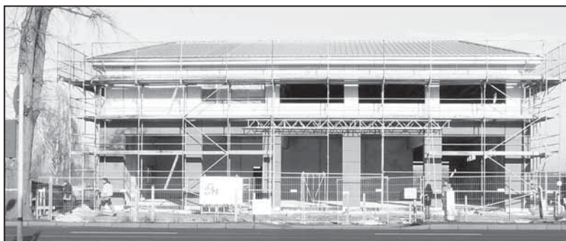
Das neue Gerätehaus der Vogelsdorfer Feuerwehr in der Frankfurter Chaussee
