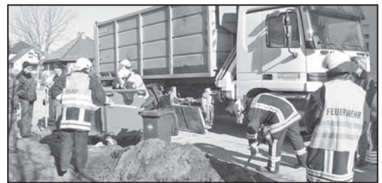
Die Kameraden beim Erdaushub und dessen Verladung in ein Entsorgungsfahrzeug Fotos: K. Schulz
